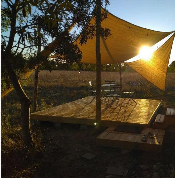
*TERRASSES AVEC VOILES D'OMBRAGE FACILEMENT DÉMONTABLES GRÂCE À UN SYSTÈME DE POULIES, SUPPORT : PIQUETS CHÂTAIGNER*
